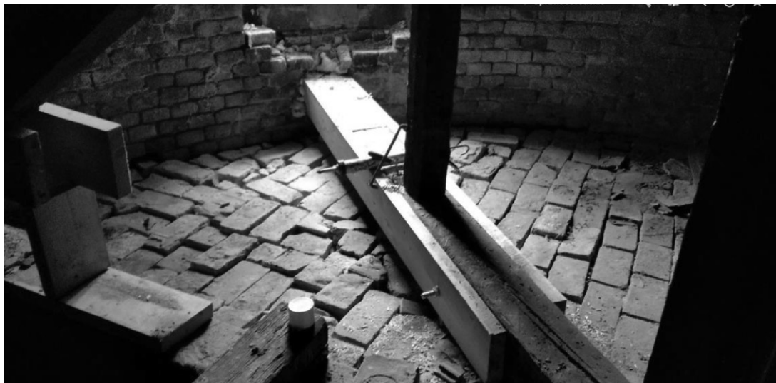
Odstraňovanie poškodenia časti krovu, Palisády 53
