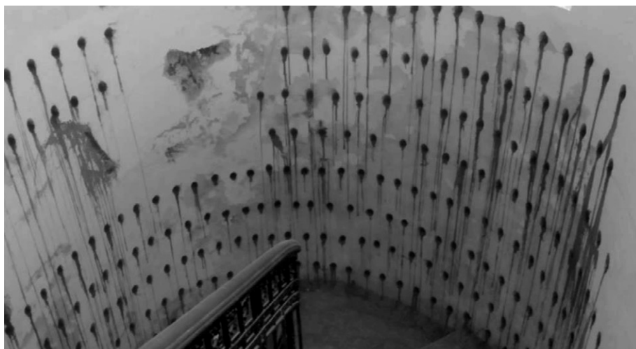
Otvory pre chemickú injeckáž stien proti vlhkosti, EDS
