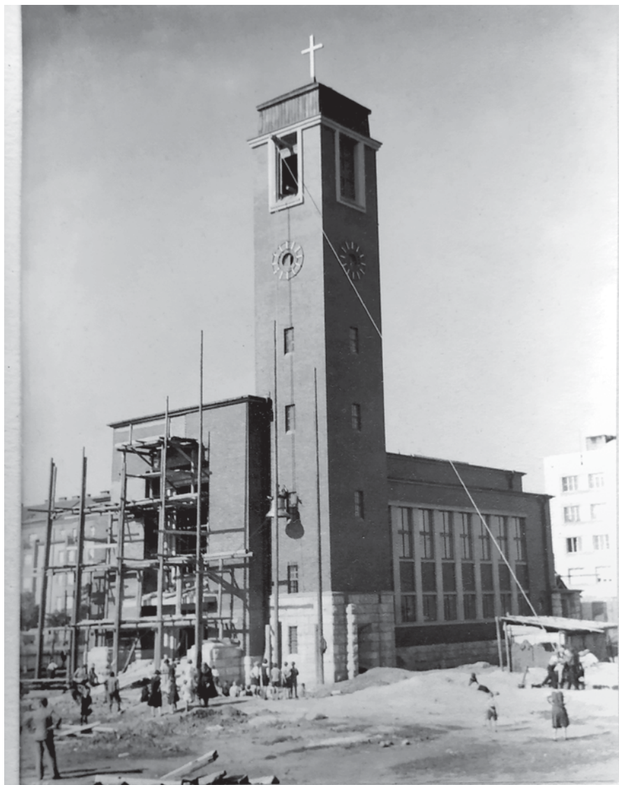
Bratislava stavba ev.kostola na Legionárskej ul. 1933
