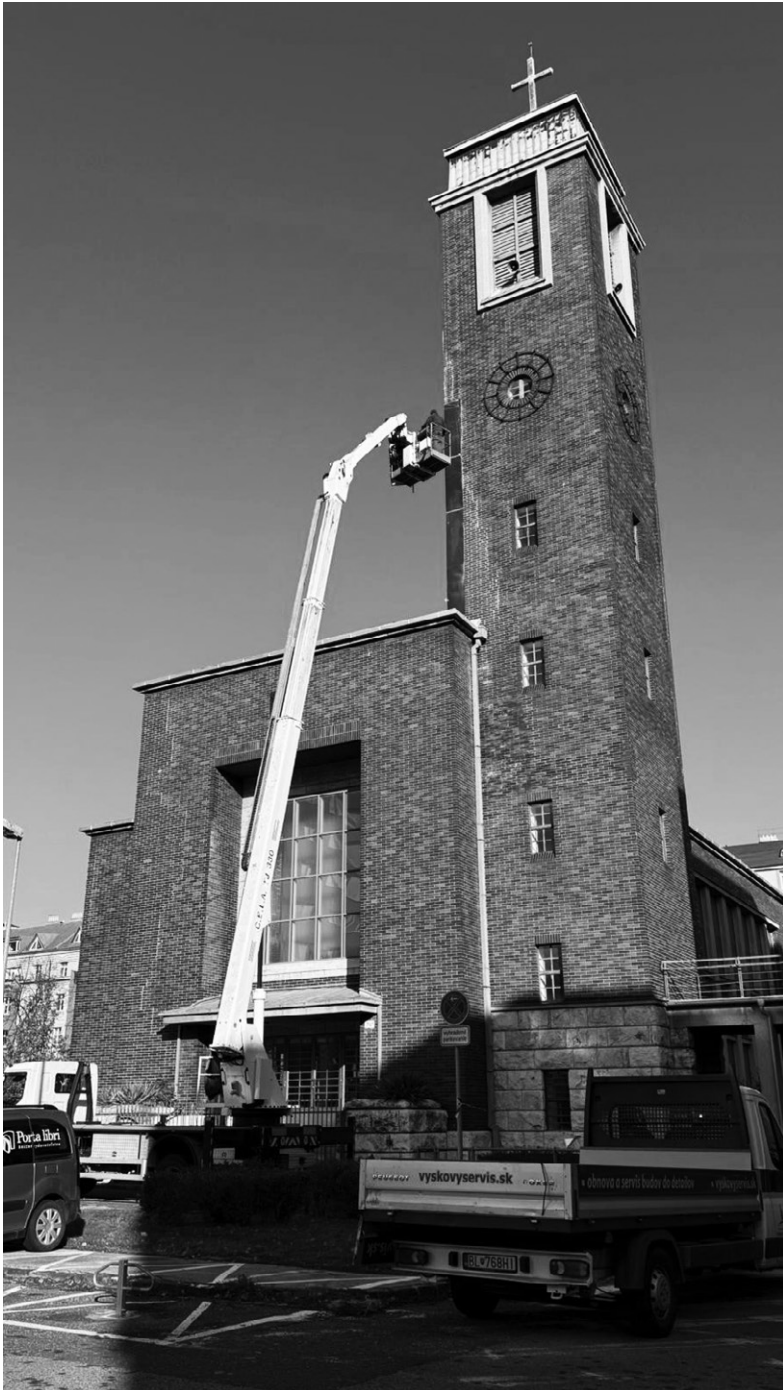
Zabezpečovacie práce na veži
